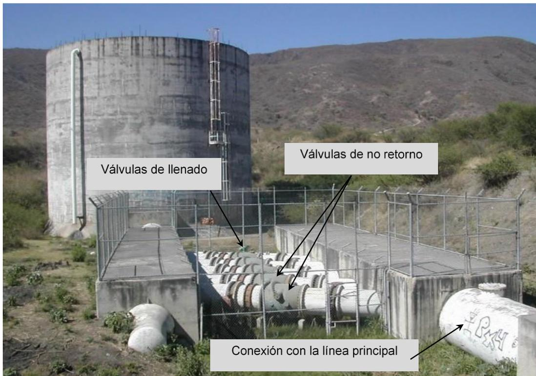
**Figura 4.18** Tanque unidireccional y el arreglo de válvulas para conectarlo a la línea principal del acueducto Chapala-Guadalajara, Jal., México. Cortesía de Rafael Carmona
