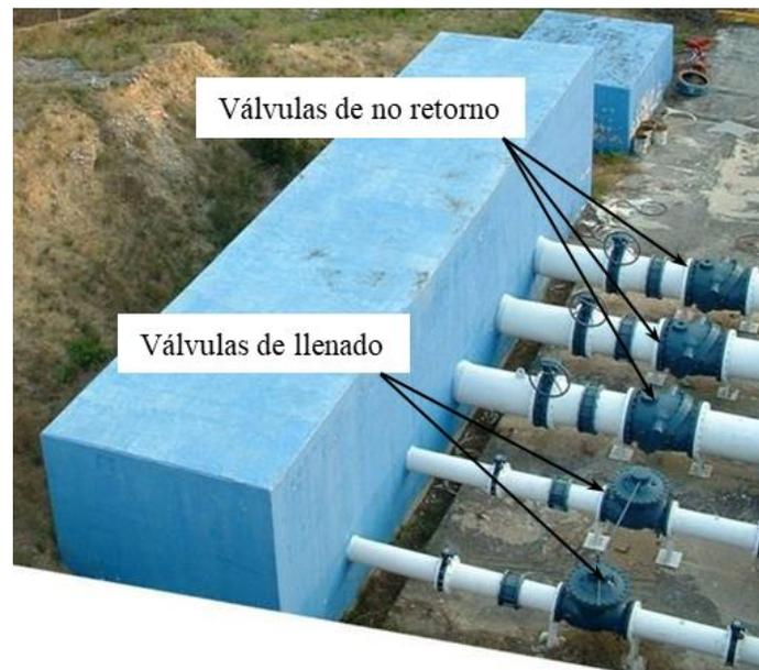
**Figura 4.19** Arreglo de válvulas de uno de los tanques unidireccionales del acueducto Linares Monterrey. Cortesía de Rafael Carmona
