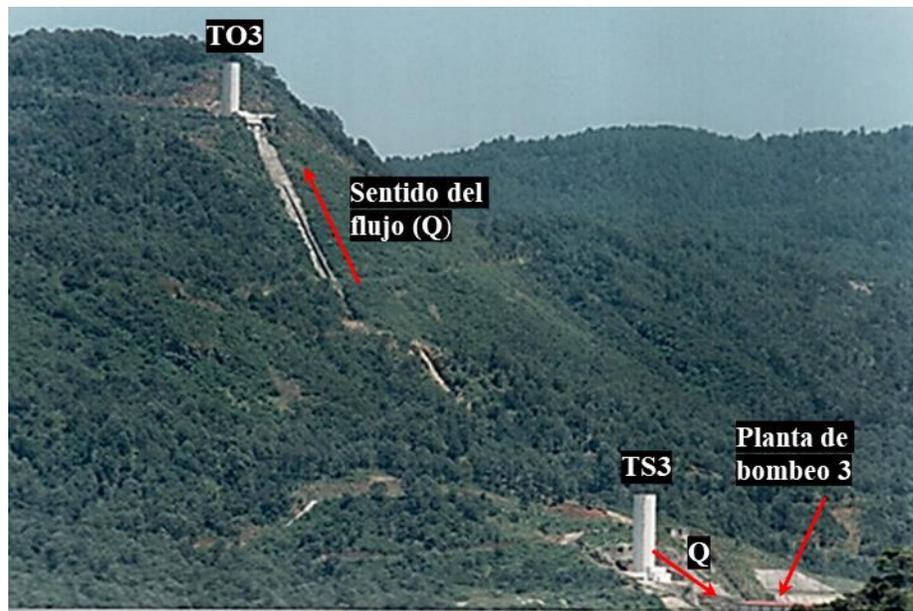
**Figura 5.3** Acueducto ascendente. En paros del bombeo, las bombas son protegidas con válvulas que al cerrarse impiden el flujo de agua que retorna hacia las bombas, de tal forma que se evita que éstas giren en sentido inverso a altas velocidades. Tramo de bombeo TS3-PB3-TO3 del Sistema Cutzamala. Cortesía de Rafael Carmona
