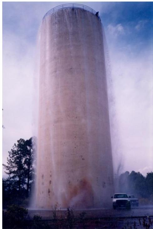
**Figura A1.3** Torre de oscilación con agua derramando. Cortesía de Rafael Carmona
