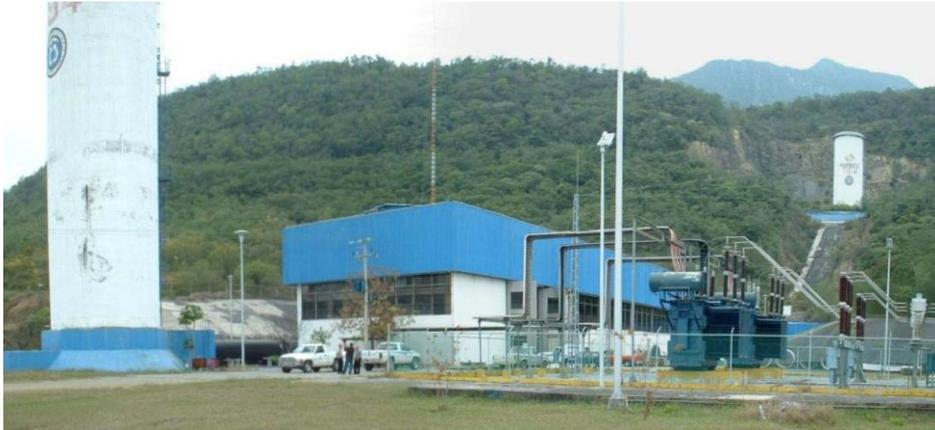
**Figura 4.9** Torres de oscilación, una ubicada aguas arriba de la planta de bombeo (torre de sumergencia) y la otra aguas abajo. Acueducto Linares-Monterrey, Nuevo León, México. Cortesía de Rafael Carmona Paredes
