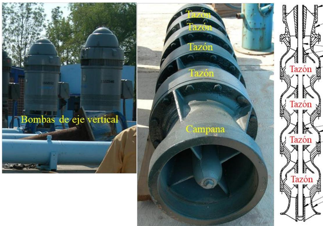
**Figura A10.4** Bombas verticales de succión simple y cuatro pasos (cuatro tazones), Santa Rosa León, Guanajuato. Cortesía de Eduardo Rodal
