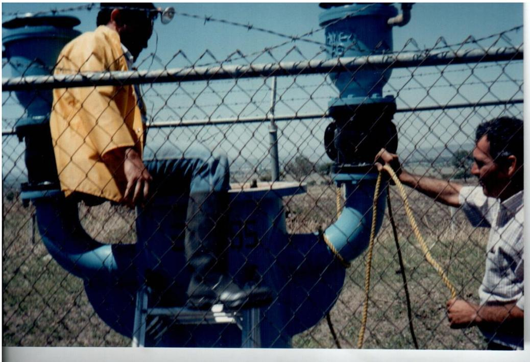
**Figura 4.21** Válvula de admisión y expulsión de aire en el acueducto El Cuchillo Monterrey. Cortesía de Rafael Carmona
