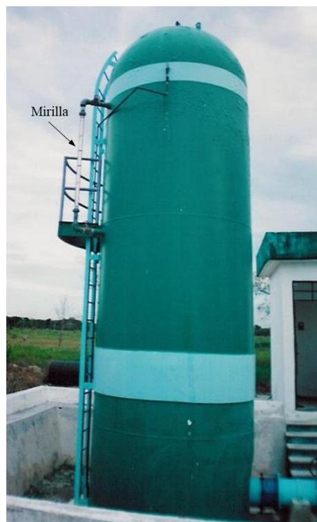
**Figura 4.13** El nivel del agua en la cámara se revisa a través de una mirilla. Cámara de aire en el acueducto González Ortega II - Ucum II - Chetumal. Cortesía de Alejandro Sánchez Huerta
