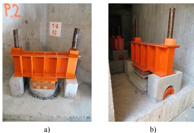
**Figura 9.9** a) Pilote de control nuevo hincado en segmentos de 91 cm, y b) pilote de fricción existente transformado a pilote de control
