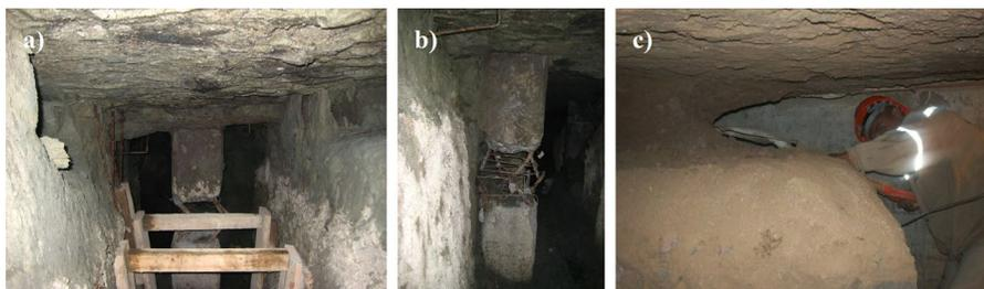
**Figura 9.17** Figura 9.17 a) Túnel de acceso y zonas de subexcavación, b) desconexión de un pilote de fricción de la cimentación original, y c) técnica de subexcavación manual
