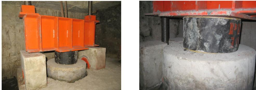
a) Sistema de control completo con cilindro polimérico
