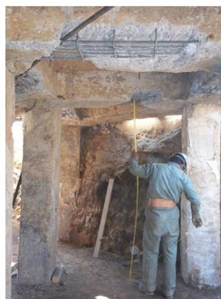
c) Retiro de recubrimiento en elementos estructurales
