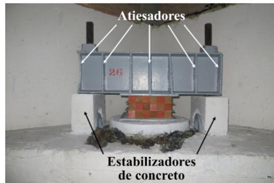
**Figura 2.8** Sistema de control con mejoras adicionales después del sismo de 1985
