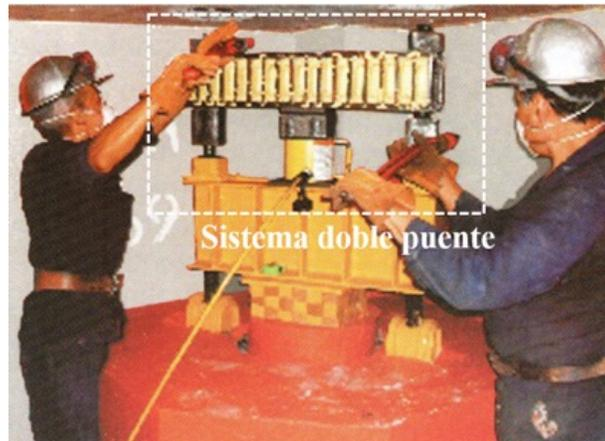
**Figura 3.2.** Sistema *doble puente* utilizado para precargar un pilote de control con cabezal sencillo (PICOSA, 2010)
