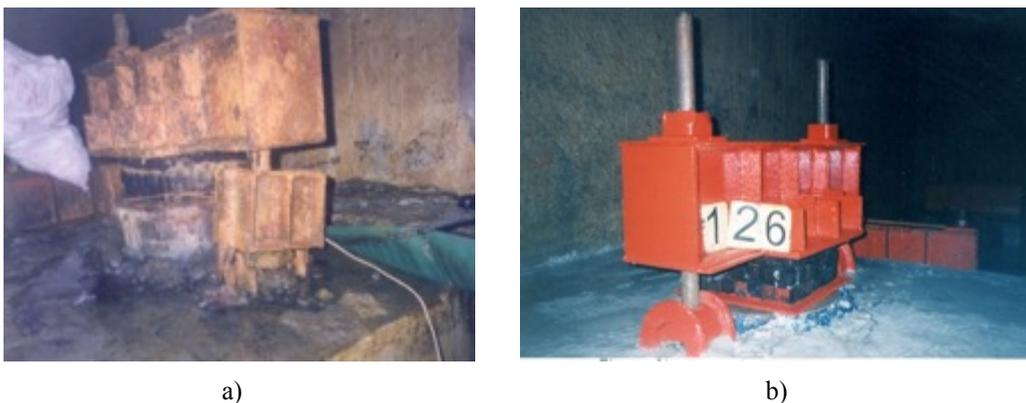
**Figura 5.9** Pilote de control en condiciones severas de abandono (cortesía de G. Verano): a) condición inicial, y b) condición final (después de una intervención especial)
