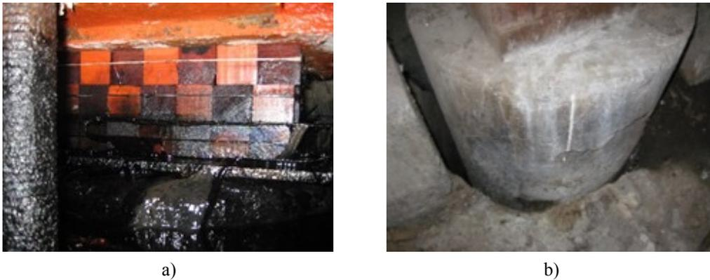
**Figura 5.8** Pilote de control en un ambiente húmedo: a) cubos húmedos; b) pilote de control sin estopero (sello hidráulico a base de estopa y brea)
