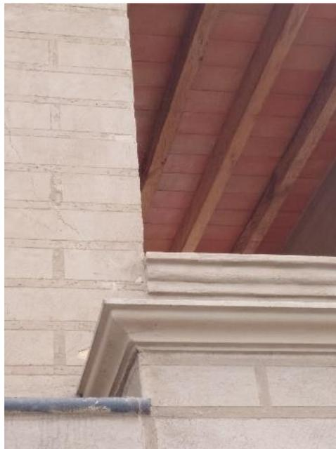
**Figura 6.41** Construcción con ladrillos de tierra en Cuernavaca, Morelos
