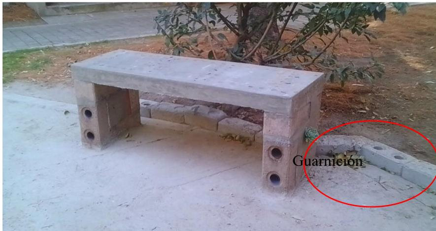
**Figura 6.43** Construcción de una banca y guarnición con bloques-AR, IIUNAM.
