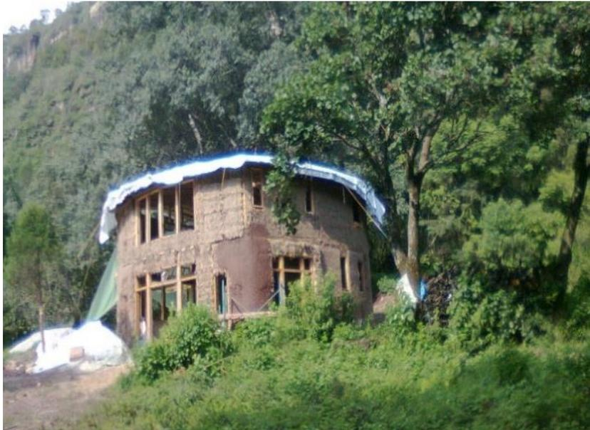
**Figura 6.42** Construcción de una casa con ladrillos de tierra cruda en Chalmita, Morelos
