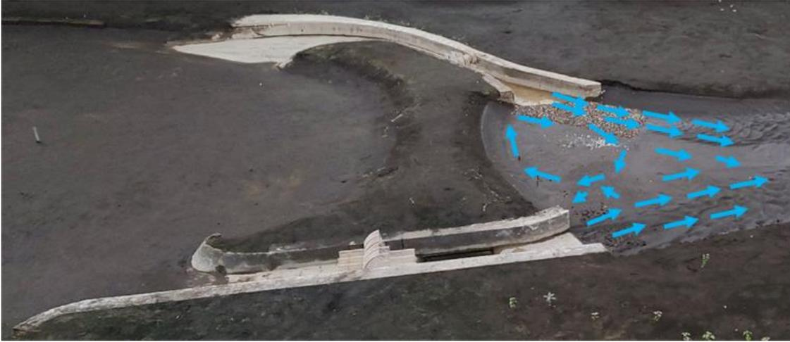
**Figura 1.7** Esquema del flujo en las zonas de recirculación, en la descarga de los canales. *Fuente: foto tomada por el autor*
